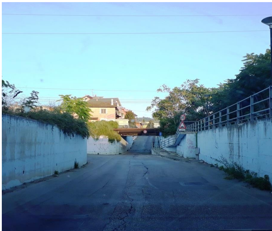
Figura 37. Sottopassaggio alla fine di Via Aterno.
