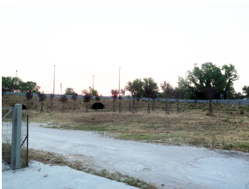
Figura 25. Vasca 5, porzione ad ovest del ponte.
